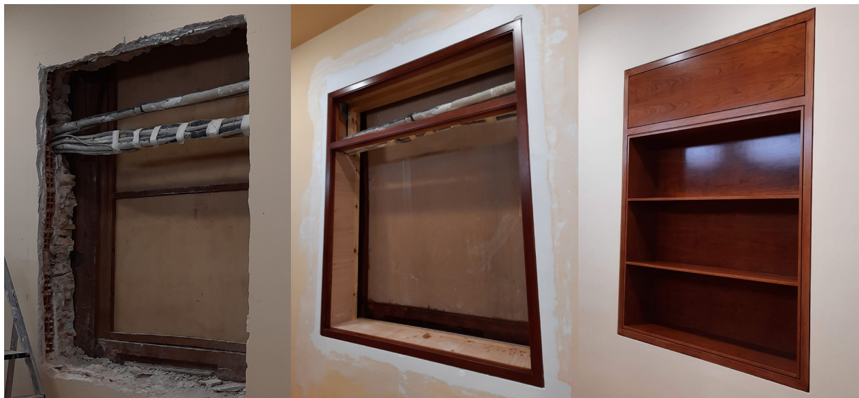
Proceso de apertura del vano. / G.M.
