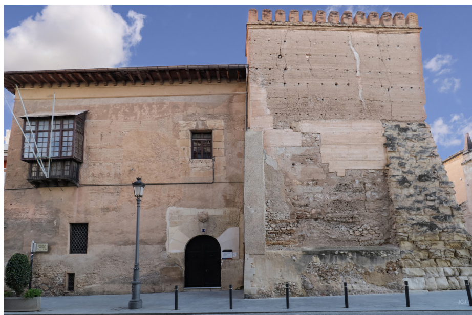
Fachada norte y entrada a la Calahorra.
