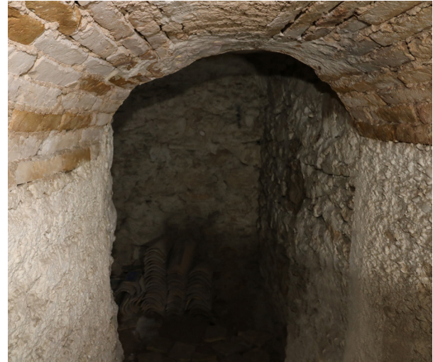
Uno de los túneles tapiados de la Calahorra.
