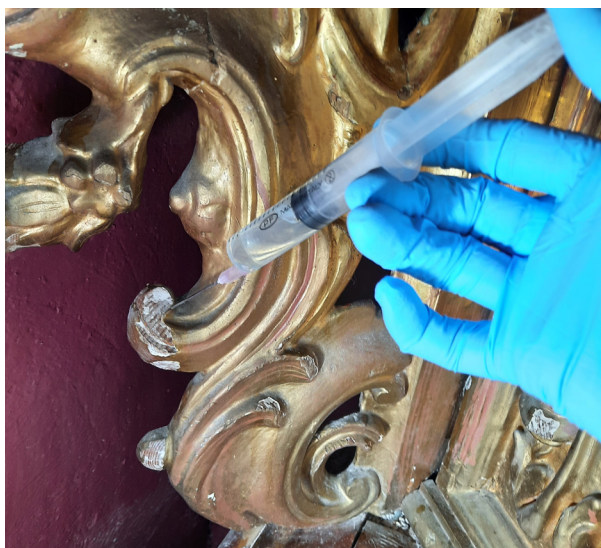
Consolidación de estratos mediante inyección. / G.M.
