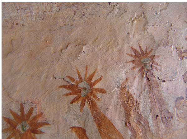
Detalle de repintes, desniveles de los estucados y levantamiento de los distintos estratos debido a una pérdida de adherencia de entre ellos. / G.M.
