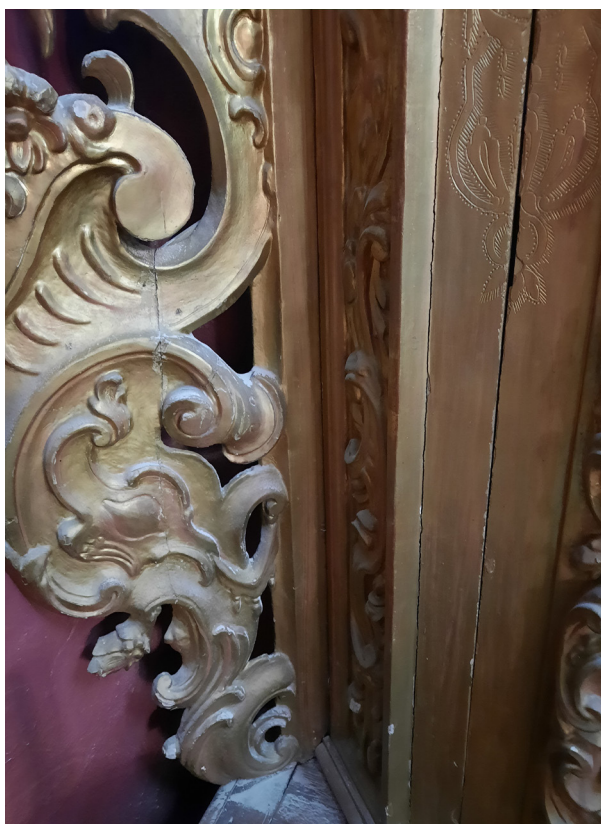
Estado de conservación: grietas en el soporte leñoso, repintes dorados sobre el oro, faltantes, y una gruesa capa de suciedad. / G.M.
