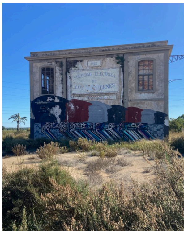
Edificio de Los Almadenes en la estación del ferrocarril de Crevillente. Pese al deterioro, todavía se distingue el año, 1922, el nombre “Sociedad Eléctrica de Los Almadenes” y la función, “Estación Transformadora nº 2”. / Foto del autor (19-12-2022).
