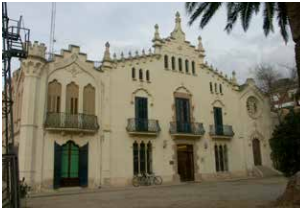
Fig.5 Reforma de fachada de Can Ginestà (1915, Sant Just Desvern). / Fuente: 'Inventario general del Modernismo'.
