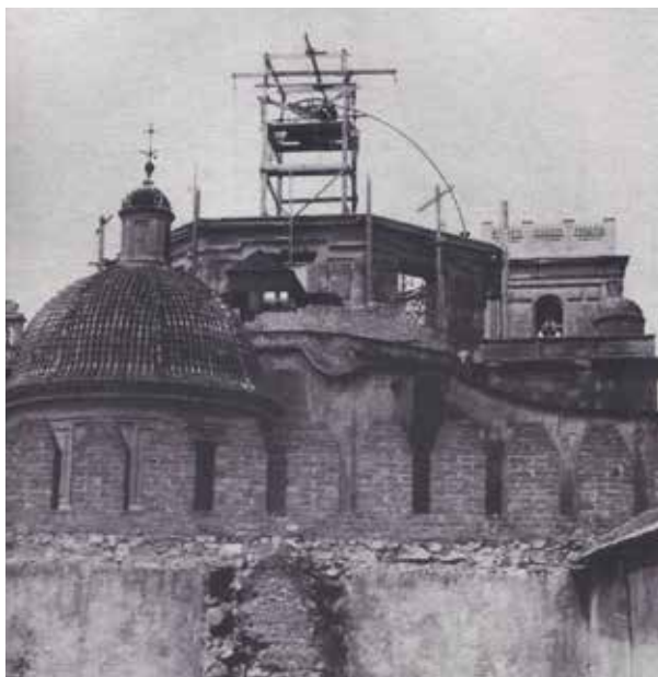
Fig.18 Foto de inicio de la construcción de la nueva cúpula de la Basílica de Santa María. / Fuente: 'Les Emprems del Temps'.
