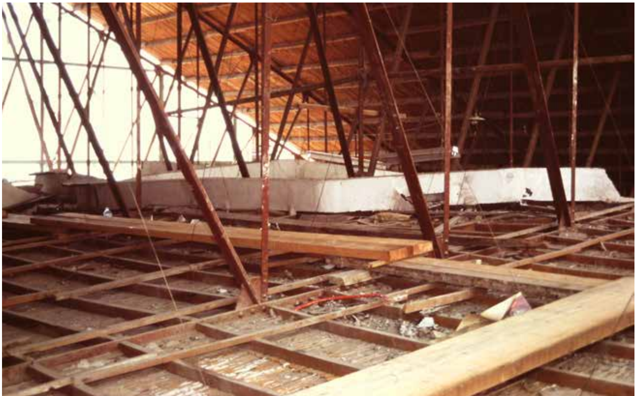
Revisión y refuerzo de la cubierta.
