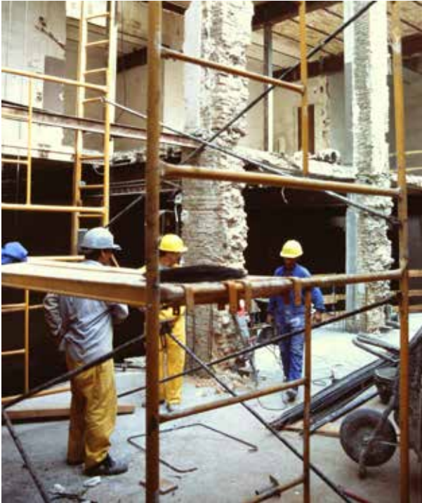
Trabajos de demolición del antiguo edificio.
