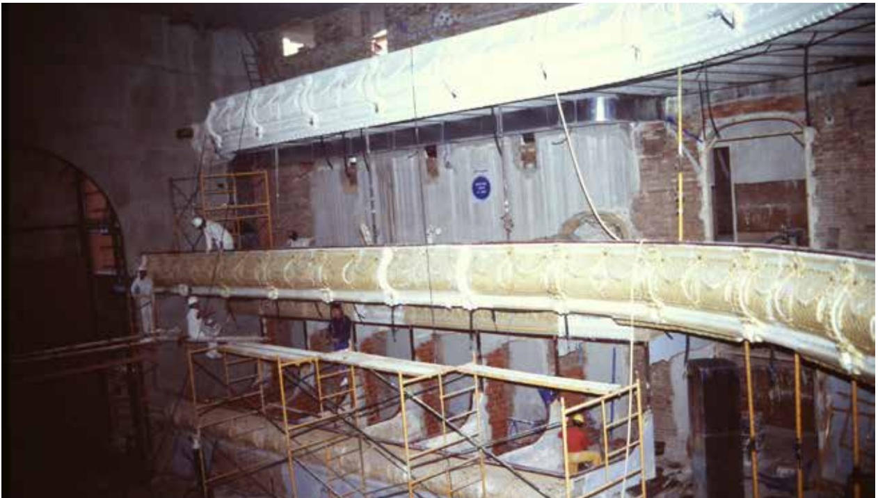
Montaje de los anillos superiores.
