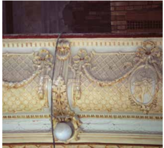
Instalación del alumbrado.
