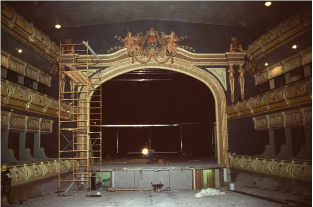
Comienzo de los trabajos de pintura.
