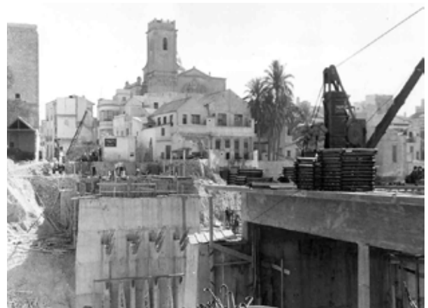
Obras de construcción del puente de Altamira a principios de la década de los sesenta. / Colección CPI.
