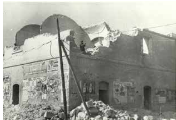
Derribo del antiguo cuartel de caballería, en el Pla (1959). / Colección Catedral Pedro Ibarra.
