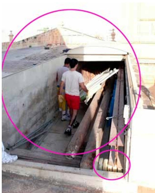
FIGURA 8. Caseta ya modificada, con cubierta corredera. En la parte inferior derecha, se observa un grupo de rodillos sobre los que se apoya la viga de celosía, lo que facilita su extracción.
