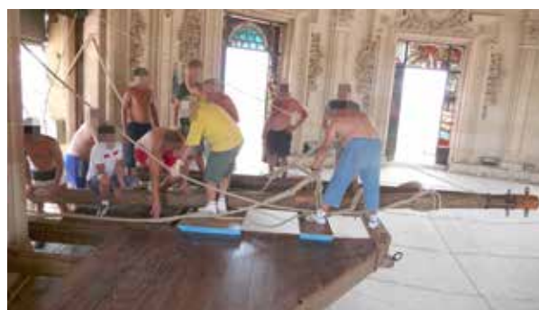
FIGURA 21. Dado que la separación entre las bases de las columnas era mayor que la anchura de la ventana, para introducir el conjunto era necesario desplazarlo hacia el interior hasta que las columnas encontraran el obstáculo de las jambas de la ventana, impidiendo que continuara avanzando. Como se aprecia en la imagen, esto provocaba que el vértice, aún sin estar debidamente sujeto, se desplazara hacia el centro del lienzo.
