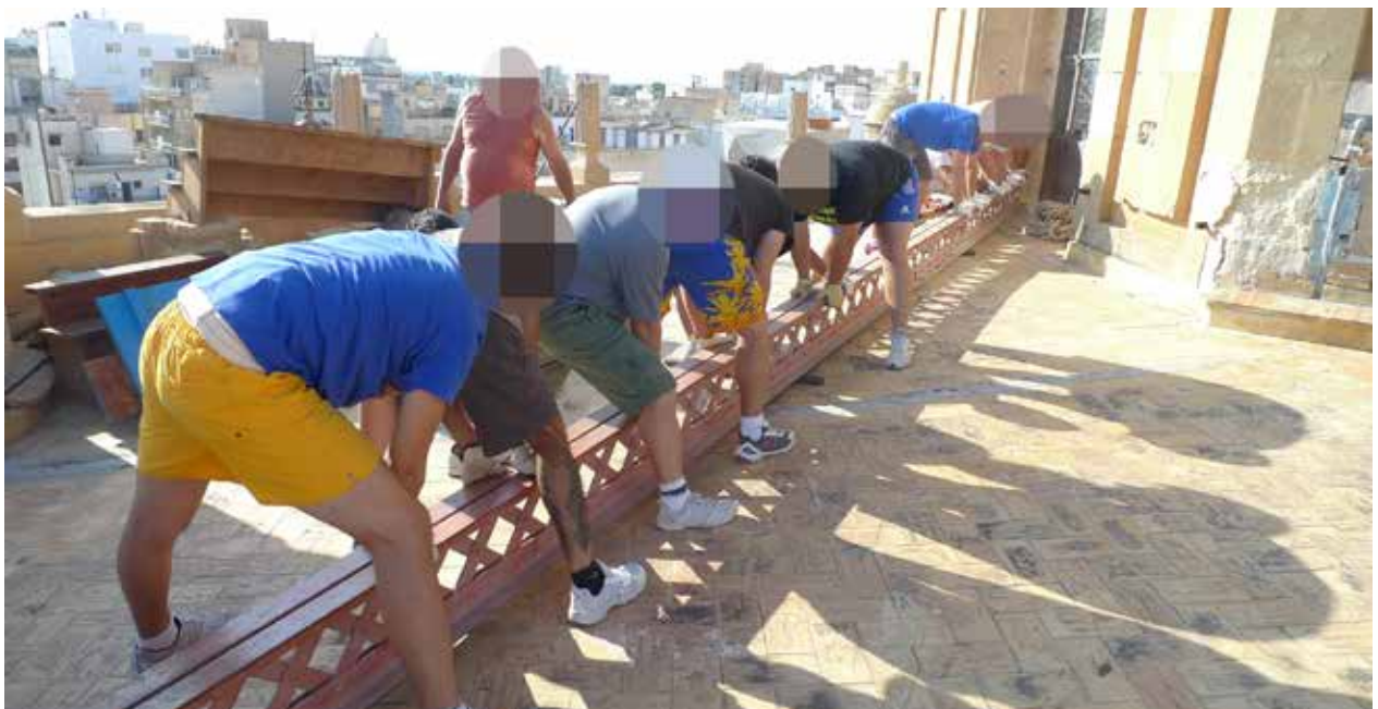
FIGURA 16. Traslado de forma tradicional de la viga de celosía desde la caseta hasta la puerta del tambor.
