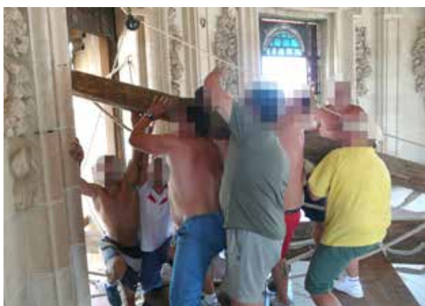
FIGURA 22. Una vez alcanzada la situación límite, se debía levantar una de las columnas hasta una altura que permitiera su paso.
