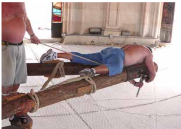
FIGURA 24. Paso siguiente: fijar el vértice mediante unión atornillada. El desplazamiento de la cabecera exigía que un tramoyista reptara por las columnas para colocar los tornillos.
