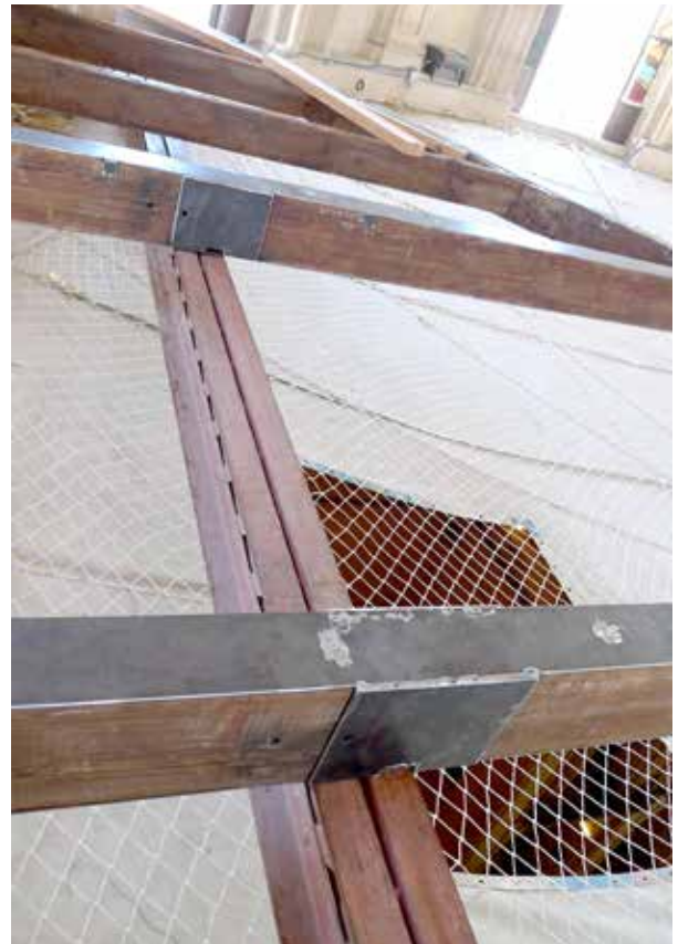
FIGURA 15. Vigas tras su restauración. Ambos cordones fueron rebajados 6 mm y reforzados con pletinas de acero adheridas con resina epoxi y reforzadas con pasadores soldados.
