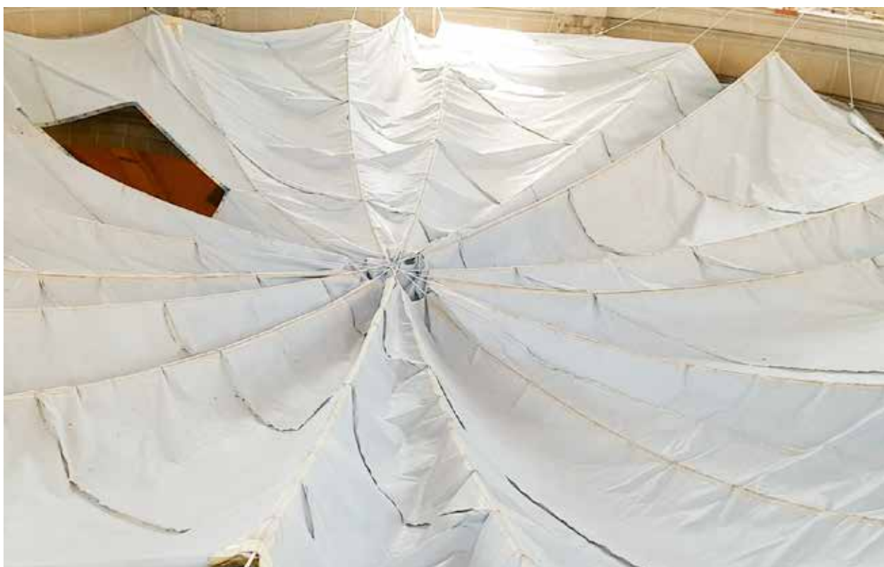
FIGURA 10. Lienzo del cielo con sustitución de tirantes radiales por diametrales, eliminando el peso de las piezas metálicas. Esta modificación redujo notablemente la deformación del lienzo. Los tirantes se cruzan en el centro obligados por una pequeña anilla.
