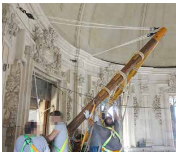
FIGURA 29. Cabria prácticamente izada con ayuda de los polipastos.
