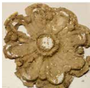
FIGURA 31. Estado de los embellecedores tras la eliminación del material empleado en remiendos anteriores.
