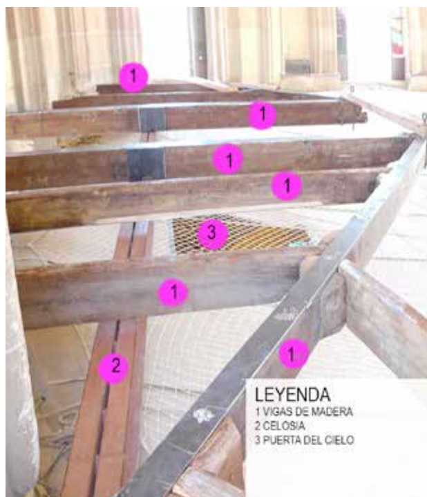
FIGURA 6. Entramado de vigas de madera y acero que conforma la estructura de la plataforma y sostiene el piso.
