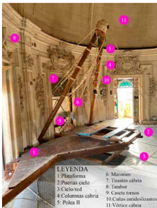
FIGURA 5. Tramoya aérea en fase de montaje, junto a una leyenda descriptiva de sus componentes.
