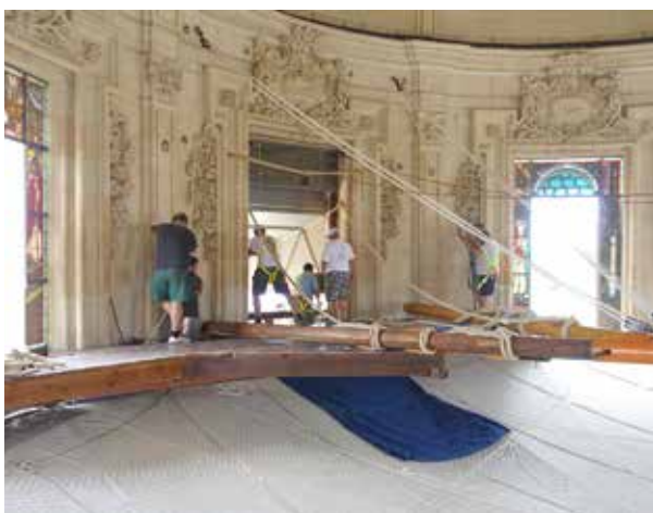
FIGURA 28. Al reducir el ángulo ( \approx 0^\circ ), las columnas pueden pasar por la ventana sin tocar las jambas. Posteriormente se abre el ángulo hasta la posición deseada sin tener que intervenir en el vértice.
