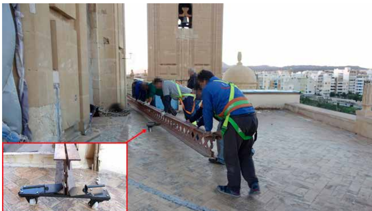
FIGURA 18. Traslado de la viga tras acoplarle un soporte con dos ruedas que facilitan el desplazamiento. Detalle del sistema de acoplamiento rápido.
