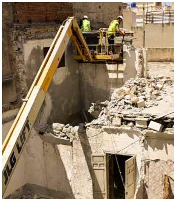
FIGURA 2. Año 2025. Obreros de la construcción derribando un edificio cumpliendo estrictamente la normativa de seguridad laboral establecida en la LPRL.
