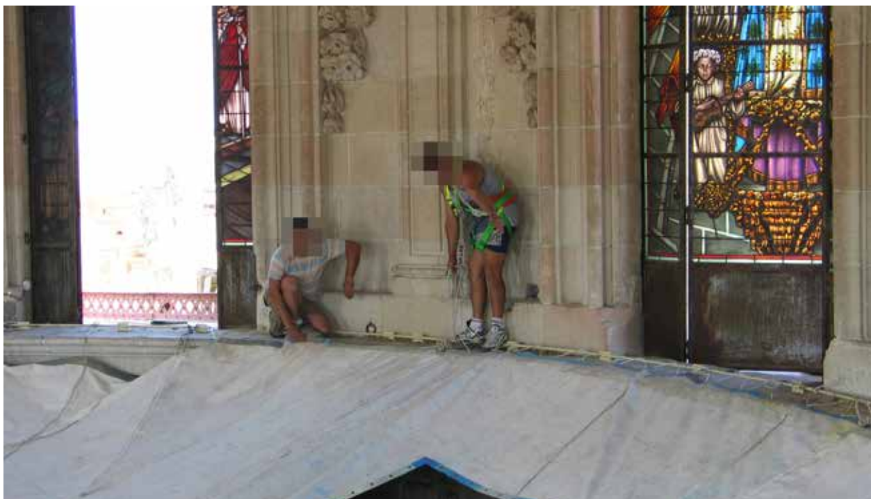
FIGURA 3. Tramoyistas trabajando sobre la cornisa del tambor. Una vez izado el cielo, es necesario ceñirlo y sujetarlo a la cornisa. Esta ha sido la forma tradicional de realizar esta labor, confiando únicamente en la pericia de los trabajadores como sistema de protección.
