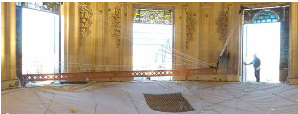
FIGURA 19. Traslado de la viga mediante sistema mecánico proyectado y construido al efecto, accionado por dos polipastos manipulados desde la terraza. Nótese la ausencia total de tramoyistas en la zona de riesgo.
