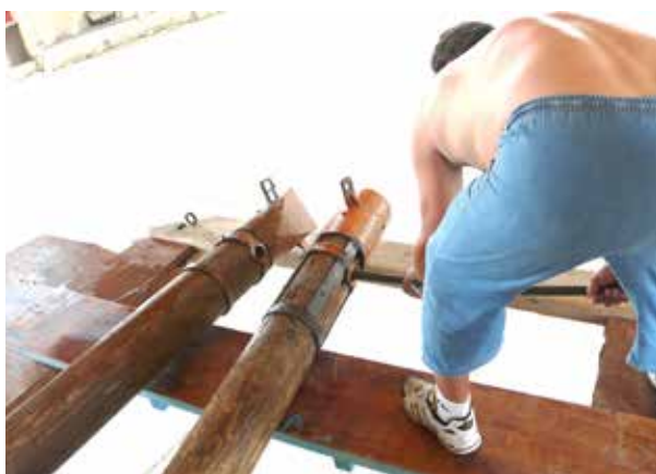
FIGURA 20. Cabecera de las columnas de la cabria antes de formar el vértice mediante unión atornillada. Se comenzaba colocando las columnas sobre la plataforma y ensartándose con una barra de acero. Esta unión le daba al conjunto bastante holgura, pero no la suficiente para que se cerraran las bases de las columnas para que cupieran por la ventana.
