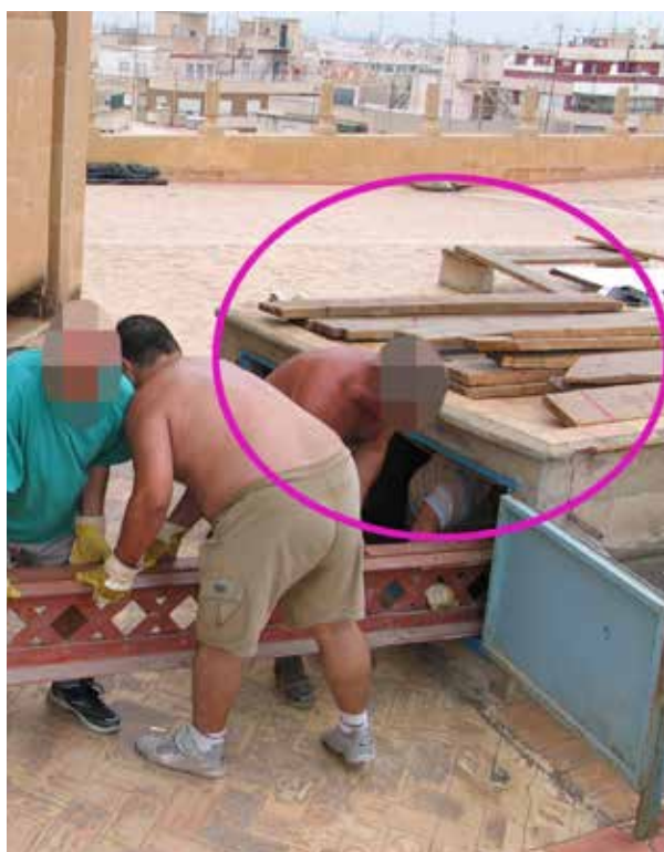
FIGURA 7. A la derecha, tramo de la caseta de vigas con su puerta de acceso antes de su modificación. En el centro, un grupo de tramoyistas extrae la viga de celosía del interior de la caseta.
