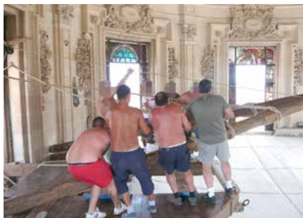
FIGURA 25. Con el vértice fijado, se izaba la cabria mediante fuerza muscular hasta su posición de trabajo, como se muestra en la figura 4.
