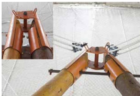
FIGURA 27. Unión del vértice mediante bulón que permite el giro de las columnas y la variación del ángulo entre ellas. Se muestra la articulación en posición cerrada, ángulo ( \approx 0^\circ ), y abierta ( 35^\circ ), con polipastos enganchados a la cabecera.
