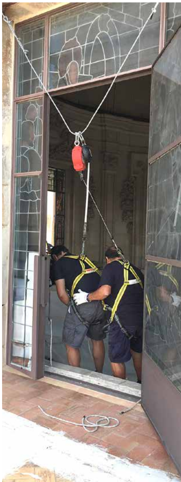
FIGURA 11. Línea de vida sujeta al dintel y conector retráctil. Este sistema reduce considerablemente uno de los mayores riesgos en las tareas de montaje y desmontaje.
